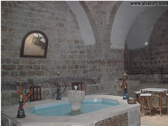
لوحة رقم (6) حمام الشفاء : إلتقاء أرجل العقود لتكوين المثلثات الكروية .
